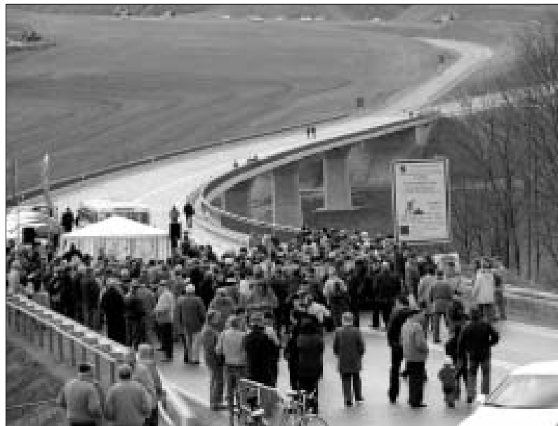
Über das Raumbachtal hinweg entstand eine neue 5,1 Kilometer lange Straße, die S 289 als Verbindung der Bundesstraßen 94 und 173.
