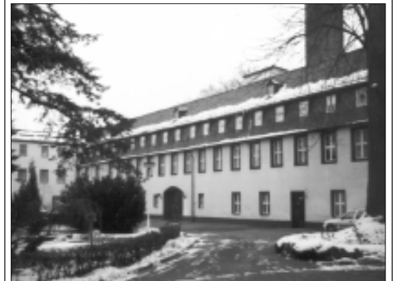
Geilsdorf, Rittergut - Hauptgebäude
