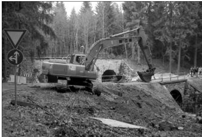
Derzeit erhält die Brücke über den Geigenbach zwischen Bergen und Werda so genannte Flügelwände, so dass später die breitere Fahrbahn von der Brücke getragen werden kann.
