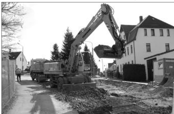
Noch ist die Auerbacher Straße in Lengenfeld eine große Baustelle. Wird an einem Ende noch gebaggert, trägt der untere Teil in Richtung Stadtzentrum bereits eine Schwarzdecke.
