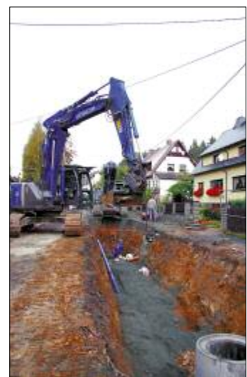
Die Firma Hoch und Tiefbau GmbH Reichenbach erneuert derzeit die Versorgungskanäle entlang der Grünbacher Straße. Foto: Dieter Krug
