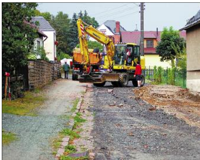
Mitarbeiter der Firma Streicher Oelsnitz entfernen den alten Straßenbelag auf der Ortsdurchfahrt Rotschau. Foto: Dieter Krug
