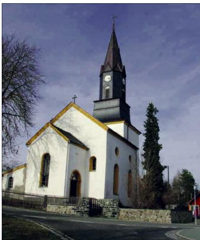
Punkt in der Dorflandschaft. Ihr Ursprung geht auf eine romanische Wehrkirche des 12. Jahrhunderts zurück. Der Außenputz zeigt deutliche Putzschäden. Die Fördermittel ermöglichen die Ausbesserung der Putzflächen, die teilweise Erneuerung der Fassade mit Kupferblech, die Sanierung aller Fenster sowie Fassadenreinigung und -anstrich.
