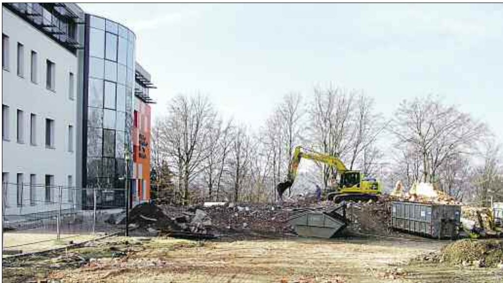
Wenn die letzten Abrissbagger abgezogen und die Überreste des alten Wismutbaus des Klinikums Obergöltzsch recycelt sind, kann das Außengelände um das neue Gesundheitszentrum in Angriff genommen werden. Auf einem Teil der Fläche entstehen 70 neue Parkplätze für die Besucher und Patienten des Gesundheitszentrums. Foto: Dieter Krug
