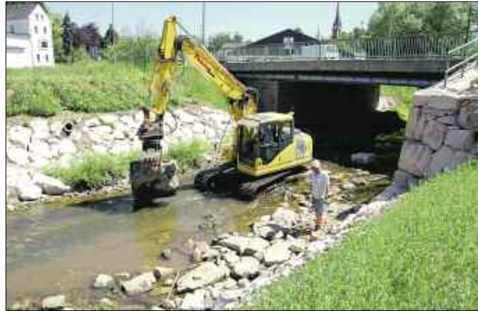
Mitarbeiter der Firma Phönix Bau sind am Unterlauf der Göltzsch in Mylau mit Bauarbeiten für den Hochwasserschutz beschäftigt
