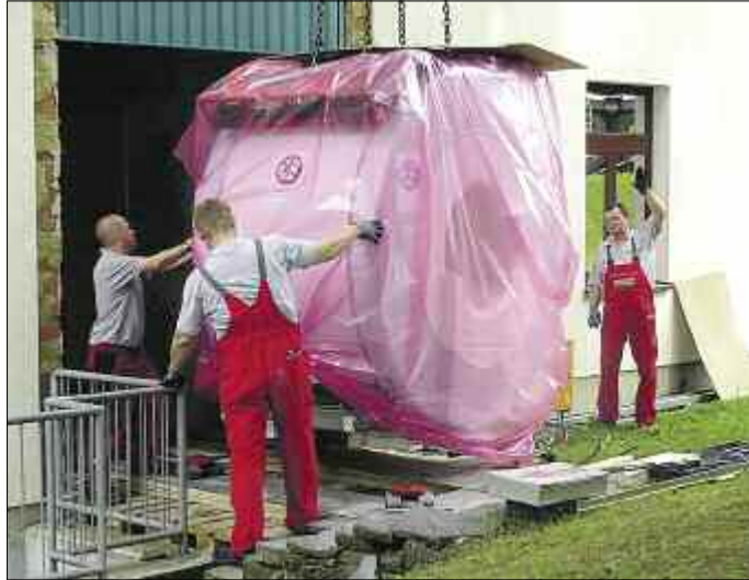
Mit einem Spezial-Autokran wurde der Magnetresonanztomograph im Klinikum Obergöltzsch Rodewisch an seinen Platz gebracht.
