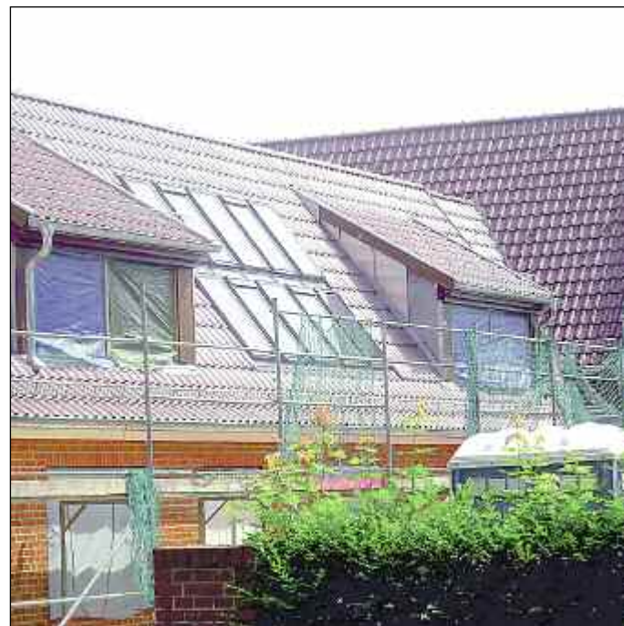
lps/Cb. Einbau von Gauben mit Isolierglasfenstern Foto: Busche
