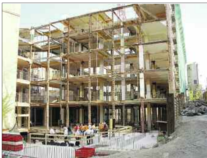
Ein interessanter Anblick und ein Bekenntnis, so die Worte des Architekten Hanns-Peter Wulf. Zwei Drittel der Altbausubstanz wird im Sinne des Tietz-Architekten Emil Rößler erhalten und wiederverwendet.
