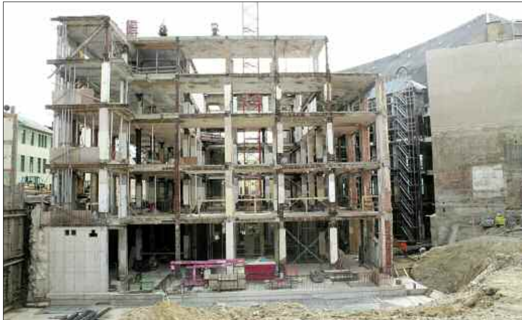
Entkerntes altes Gebäude an der Rädelstraße. Im Vordergrund sieht man einen Teil der bewehrten Bodenplatte für den Neubau.
