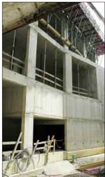
Baufortschritt am Neubau Forststraße (Blick aus dem zukünftigen Innenhof)
