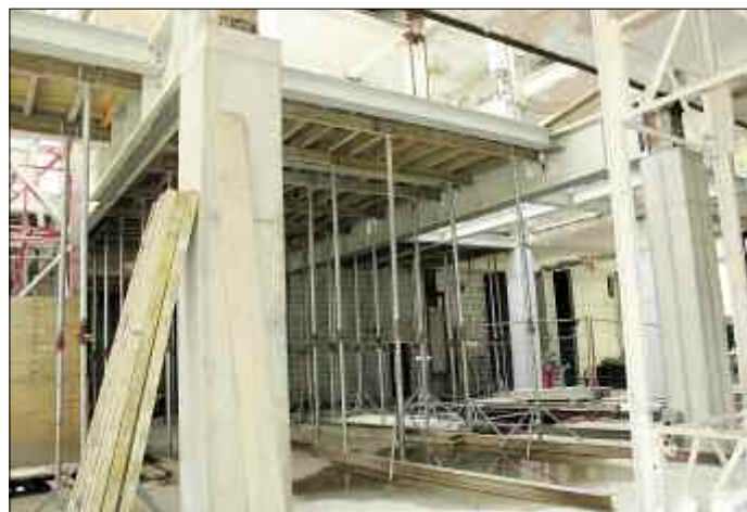
Die künftige Decke über dem neuen Sitzungssaal wird für die Betonage eingeschalt.
