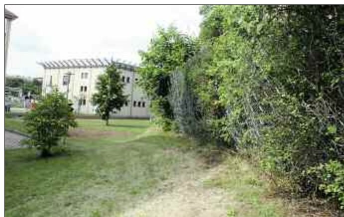
Böschungsschutz am BSZ e.o.plauen
