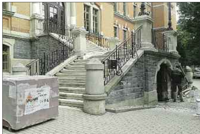
Sanierung der Haupteingangstreppe am Gymnasium Oelsnitz
