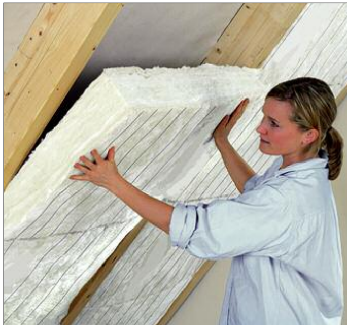
lps/Jk. Beim Ausbau des Dachbodens besonders wichtig: Die richtige Dämmung Foto: Fachverband Mineralwolleindustrie e.V., Berlin
