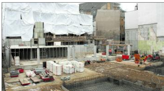
Im Vordergrund wird die Fundamentplatte für die Betonage vorbereitet (Ecke Ränisstraße/Forststraße). Dahinter (wo die Platten lagern) wird das Erdgeschoss gebaut. Foto: Landratsamt Vogtlandkreis
