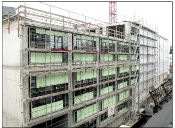
Montage der Fassadenelemente am Bauteil 2 an der Forststraße Fotos: Landratsamt Vogtlandkreis
