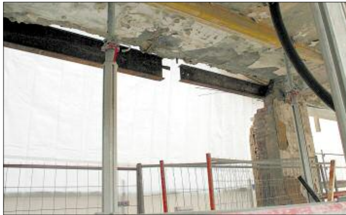
Zwei alte Träger führen hier nicht zusammen. Auch fehlen in der Altbaubsubstanz Stützen, die nur in den Bauzeichnungen vorhanden sind.
