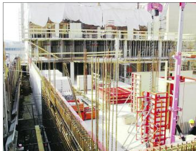
Rädel- und Forststraße: Die ersten Wände auf der neuen Bodenplatte sind bereits eingeschalet und bewehrt.
