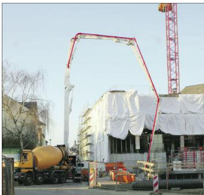
Mit dieser Betonpumpe wurde der Beton für die große Bodenplatte eingebracht.
