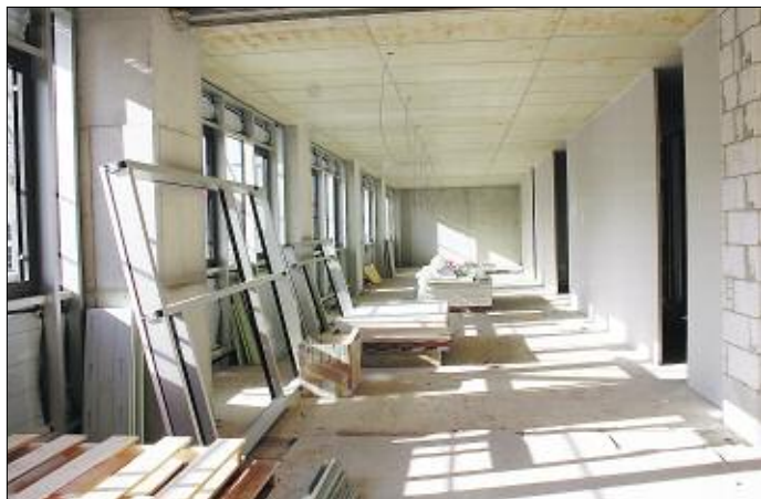
Fenster und Trockenbauwände sind installiert. Der nächste Schritt sind die Türen.
