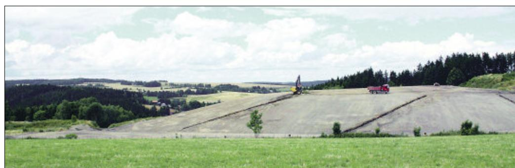
*Die Altdeponie Adorf wird neu geformt. Austretendes Deponiegas wird zur Entsorgung gefasst, die Oberfläche wird abgedichtet. Abschließend wird die Fläche begrünt.*
