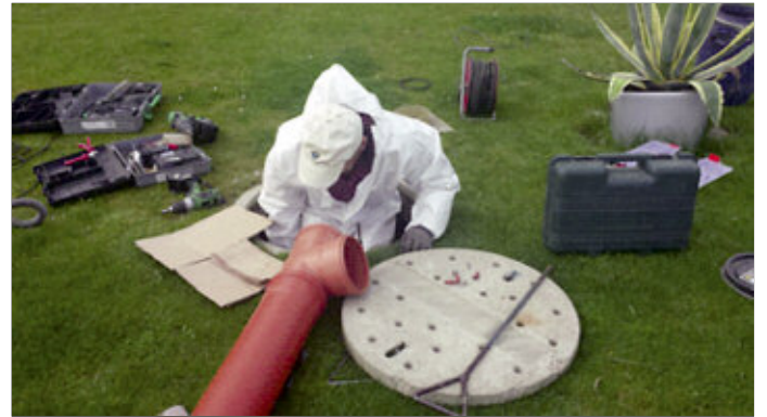
Die Umrüstung der Kleinkläranlage durch einen Monteur der Bergmann Gruppe. Fotos: Bergmann Beton + Abwassertechnik GmbH
