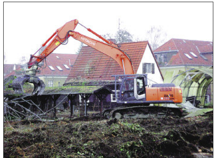
Ips/Cb. Abbrucharbeiten für ein neues Quartier
