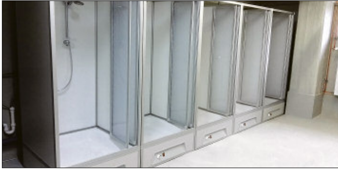
Im Keller wurden u. a. Duschen provisorisch errichtet.
