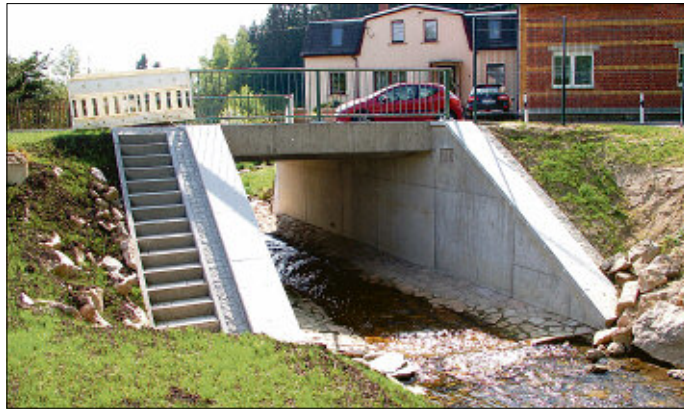
Nun kann der Verkehr über die neugebaute Brücke wieder rollen.
